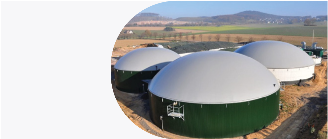
Ilustración 8. Digestión anaeróbica - Biodigestor
